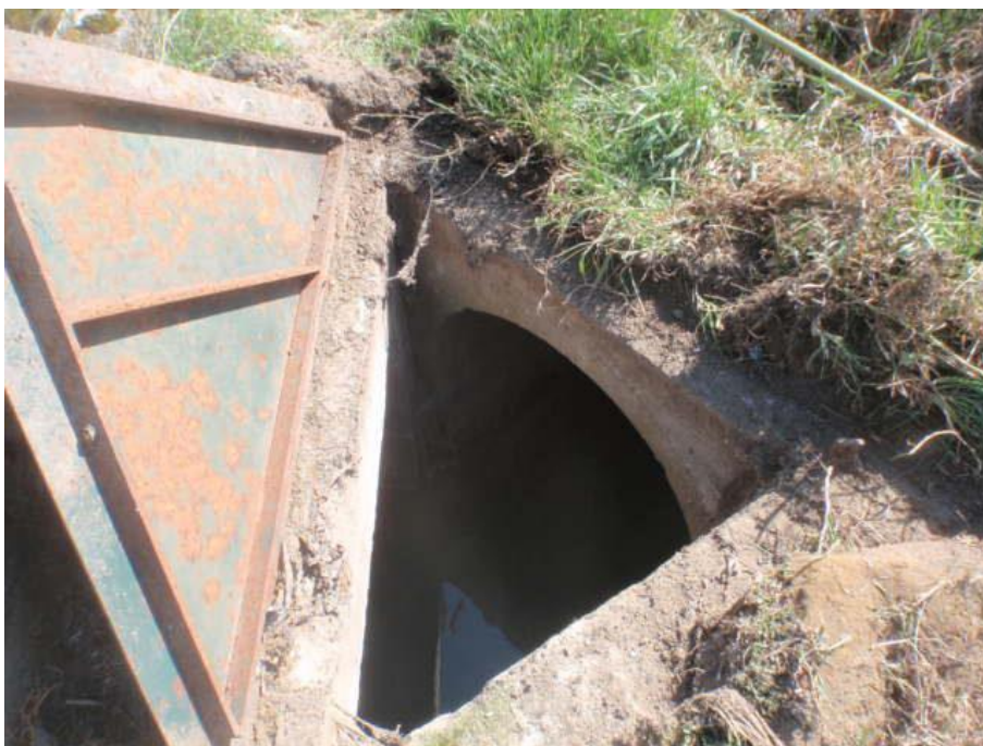
Foto 3: pozzetto vicino alla vasca di sedimentazione esistente – collettore ovoidale 800x1200 mm in cls della rete fognatura mista esistente
