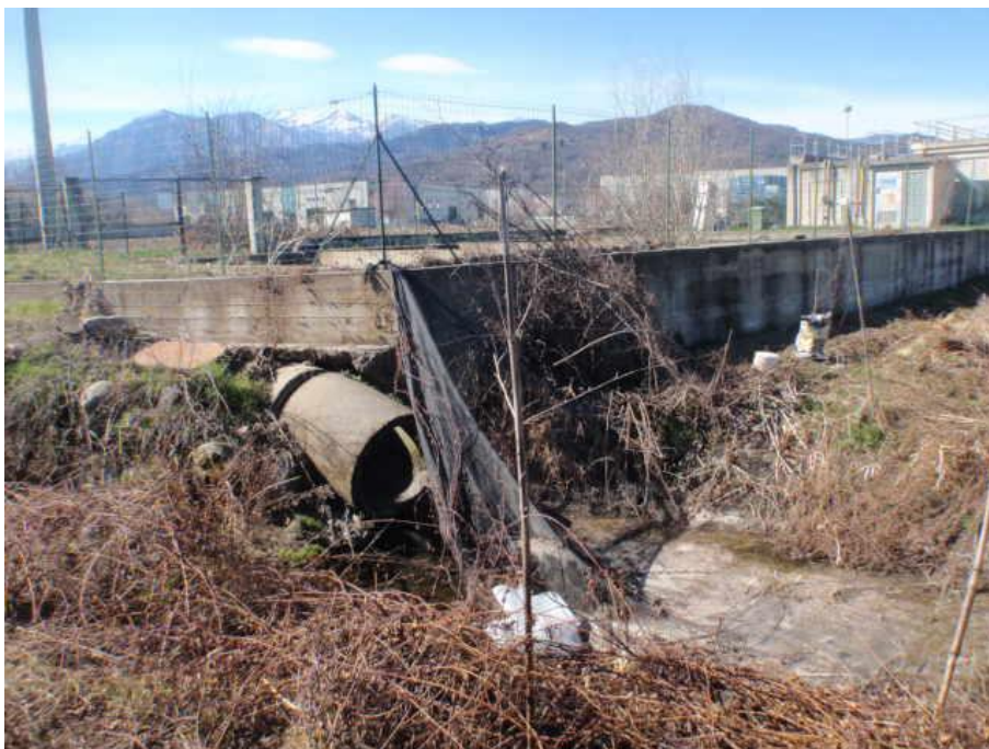
Foto 6: scarico di emergenza della vasca di sedimentazione esistente
