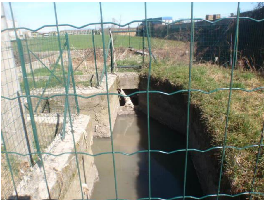
Foto 4: vasca di sedimentazione esistente
